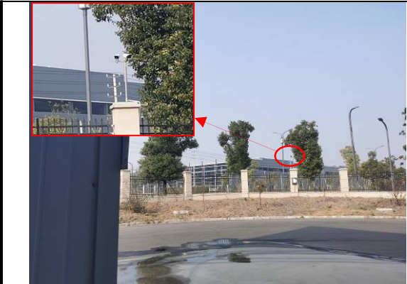
危废库外及装卸场所摄像头
